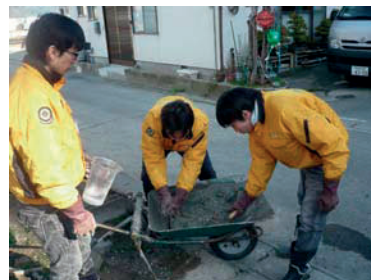
モルタル補修作業
